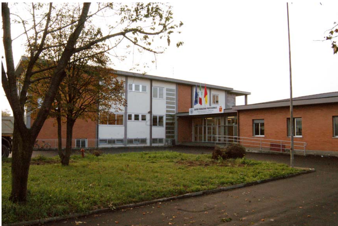
vista dell'edificio istituto C.F.P.
