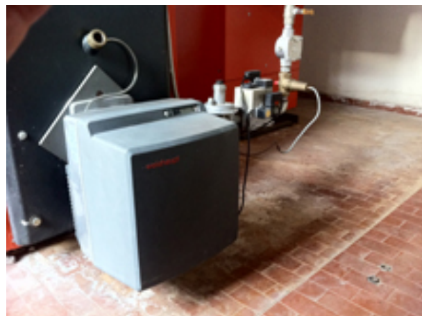
BRUCIATORE ( 1 ) Locale Caldaia
