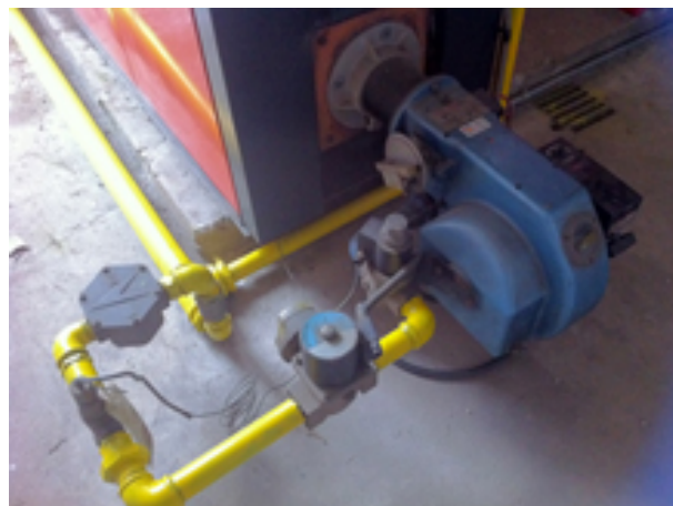
Bruciatore ( 1 ) Locale Caldaia Esterno
