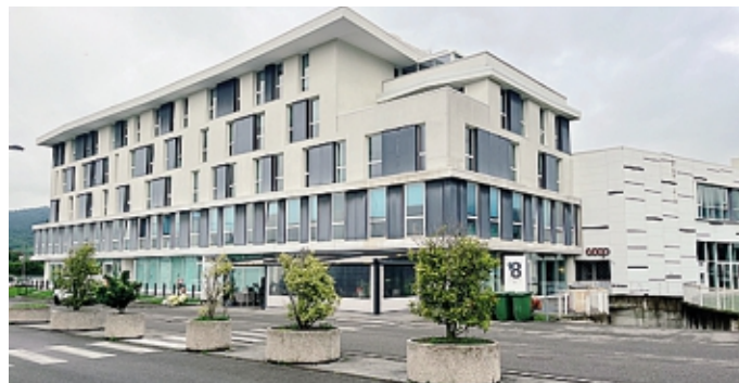
L'area commerciale di via Volta, di fronte al piazzale dell'Albarotto
