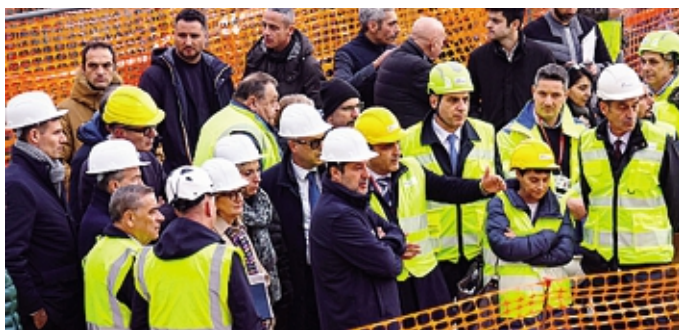
Il sopralluogo del ministro Salvini al cantiere del treno per Orio BEDOLIS
